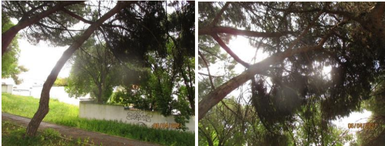
Fig. 5 – Pinheiro muito inclinado sobre um caminho e o muro de uma moradia próxima.
